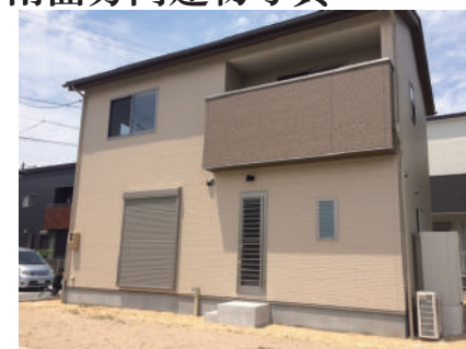
正面方向建物写真
